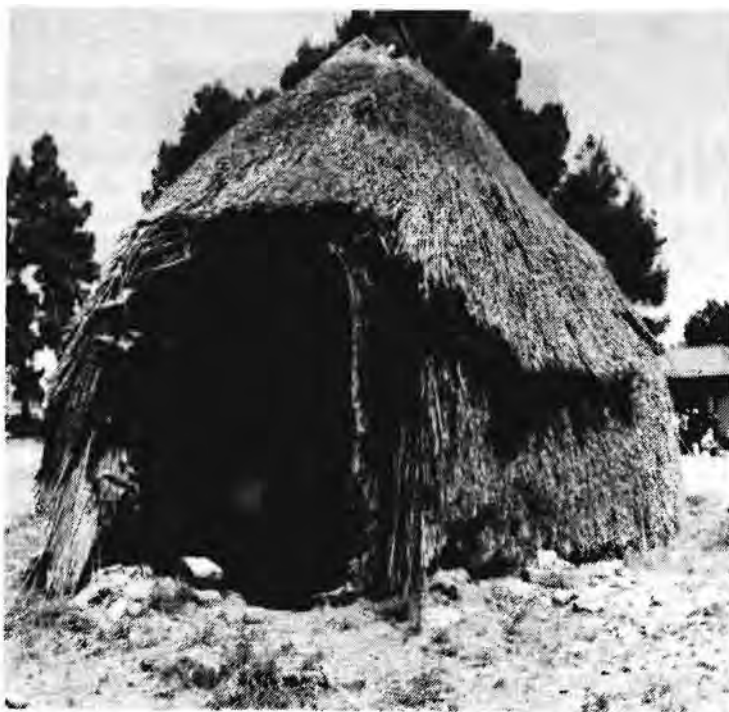
Die hutte by ha Mmamate in die Kolonie-area naby Teyateyaneng is na bewering deur afstammelinge van Masopha, die seun van Moshoeshe, gebou. Die struktuur het 'n kort ingangstonnel of mathule met 'n lae klipmuur onder die raamwerk van latte wat die dekgras stut. Latte en gras is met gevlegte grastou gehê. Die hut is tot op 'n hoogte van 1,8m aan die binnekant gepleister en die vervalle deel van die ingang word met 'n stutpaal ( ts/ea ) versterk.
